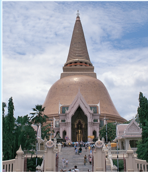
▲ พระปฐมเจดีย์ จังหวัดนครปฐม
