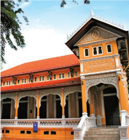
สัณฐานนอกอาคาร
