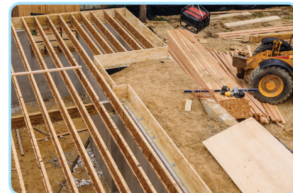
▲ พื้นโครงสร้างไม้
