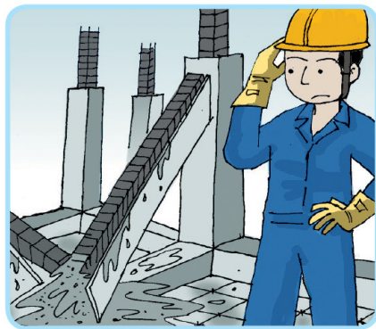
▲ ใช้ดินหรือทรายรองใต้ท้องคาน จะทำให้โครงสร้างอาคารไม่แข็งแรง
