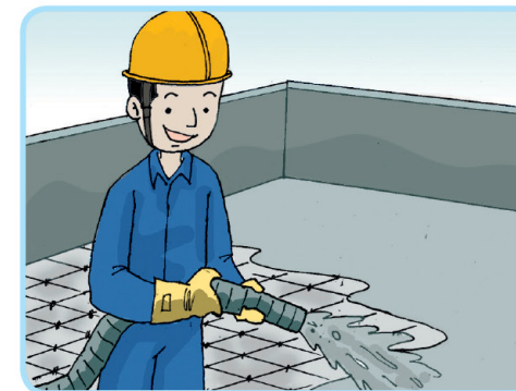
▲ ทำความสะอาดพื้นที่ก่อนเทคอนกรีต
