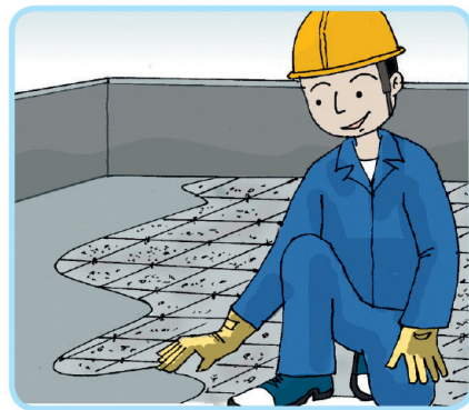
▲ ใช้คอนกรีตหยาบทับหน้าดินแล้วใช้ลูกปูนหนุนเหล็กจะทำให้โครงสร้างอาคารแข็งแรง
