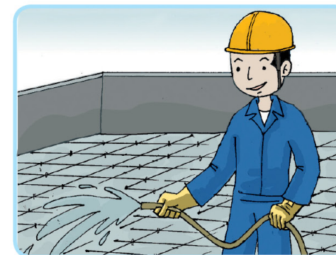
▲ ก่อนจะเทคอนกรีตต้องทำให้พื้นที่ชุ่มชื้น
