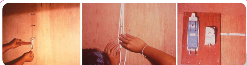
รูปที่ 1.12 การเดินสายด้วยเข็มขัดรัดสาย
