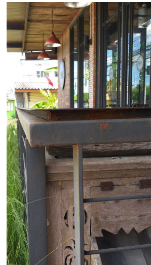
รูปที่ 1.41 ชิ้นส่วนเหล็กที่เกิดสนิมเนื่องจากสัมผัสแก๊สออกซิเจนในอากาศและน้ำ
