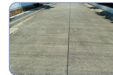
ภาพที่ 4.38 คอนกรีตที่แห้งแล้ว
