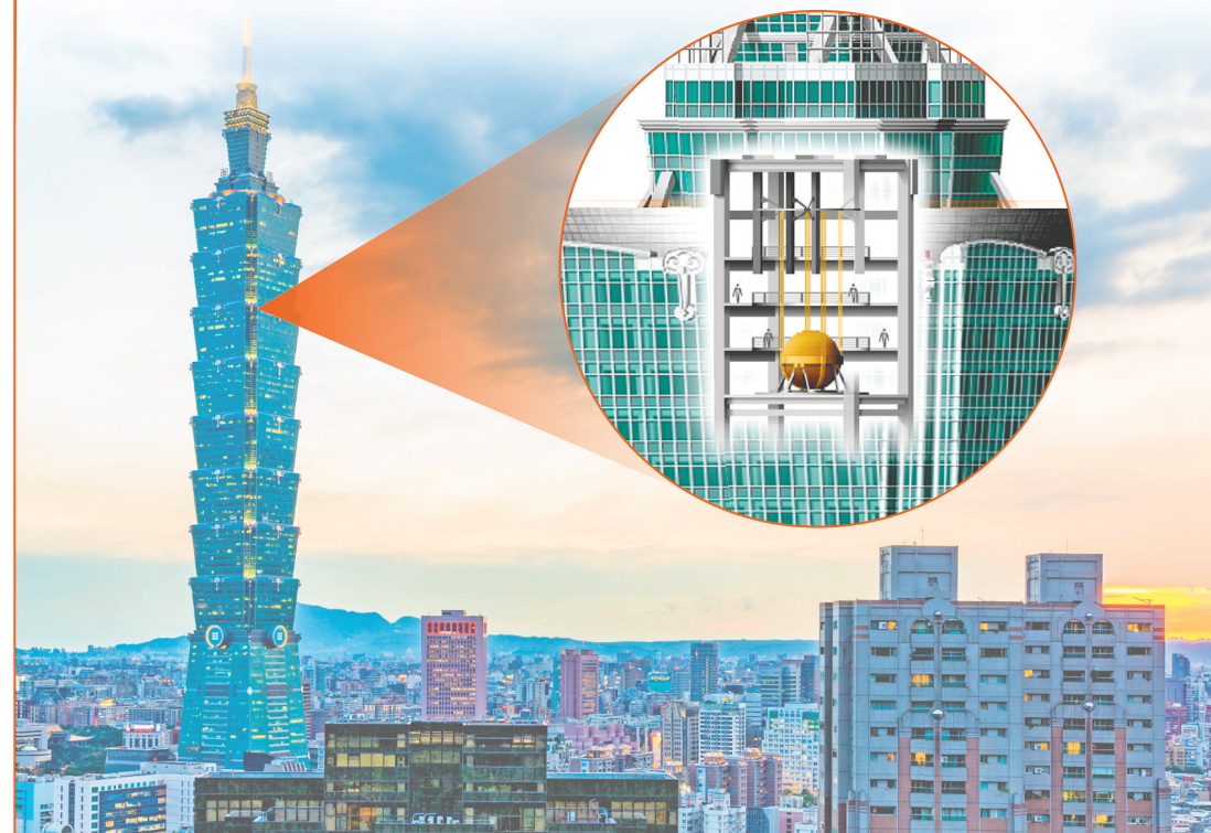
▲ ภาพที่ 1.15 ตึกไทเป 101 ที่มีการติดตั้งลูกตุ้มเพื่อลดการสั่นสะเทือนของตึก ที่มา : คลังภาพ อจท.
