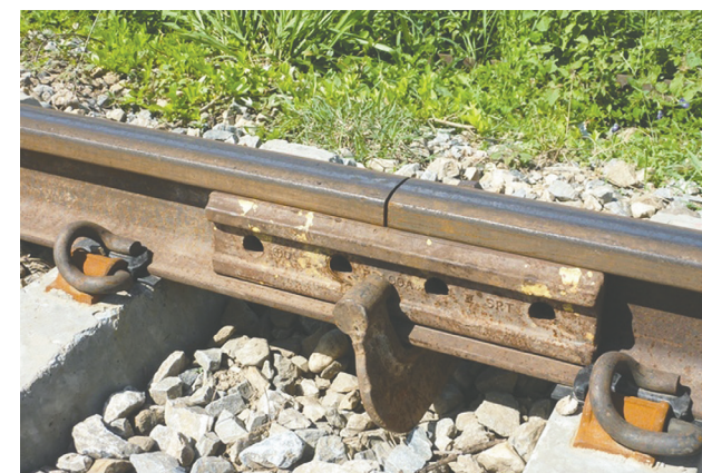
▲ ภาพที่ 4.14 การเว้นช่องว่างระหว่างท่อนรางรถไฟต้องเว้นช่องว่างแต่ละท่อนให้ห่างกันพอสมควร เพื่อรองรับการขยายตัวของรางรถไฟเมื่อได้รับความร้อนจากแสงอาทิตย์ตลอดทั้งวัน ที่มา : คลังภาพ อจท.
