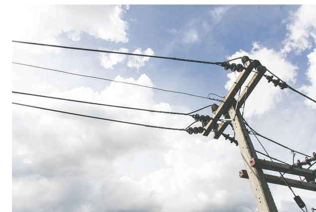
▲ ภาพที่ 4.15 การชิงสายไฟให้หย่อนพอประมาณ เพื่อป้องกันการหดตัวของสายไฟในช่วงฤดูหนาว ที่มา : คลังภาพ อจท.
