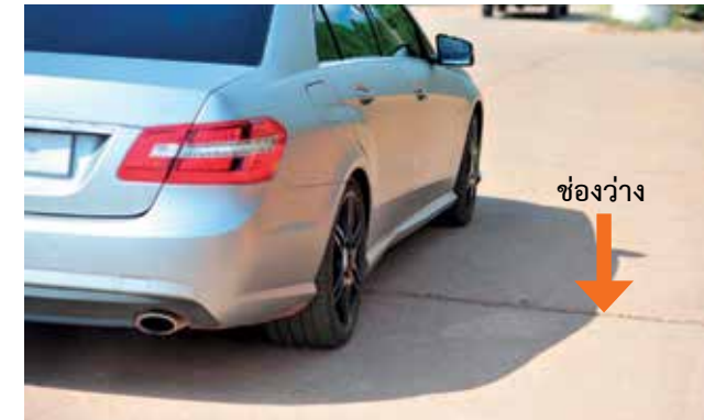
ภาพ 5.23 ถนนที่ได้รับการออกแบบให้มีช่องว่างเพื่อรองรับการขยายหรือหดตัว (ลูกศร)
