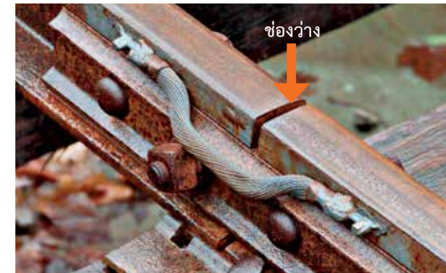
ภาพ 5.24 รางรถไฟที่ได้รับการออกแบบให้มีช่องว่างเพื่อรองรับการขยายหรือหดตัว
