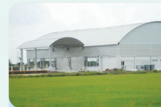
ที่ดินเพื่อสร้างโรงงานอุตสาหกรรม
