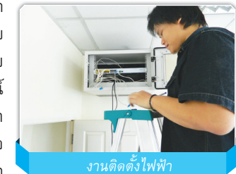
งานติดตั้งไฟฟ้า
