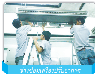
ช่างซ่อมเครื่องปรับอากาศ
