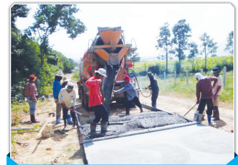
งานก่อสร้างถนน
