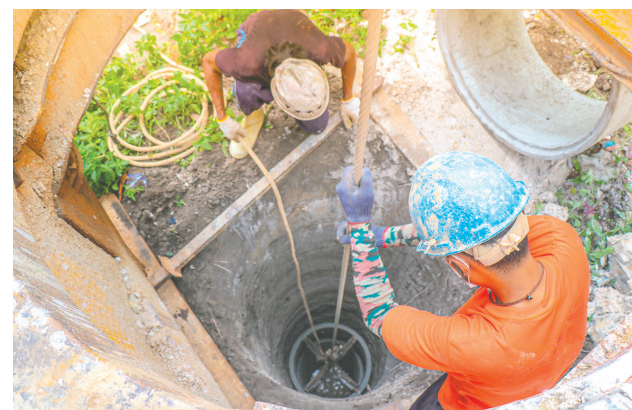
▲ ภาพที่ 5.7 การขุดเจาะบ่อบาดาลอาจทำได้ยาก เพราะต้องขุดเจาะผ่านชั้นดินและหิน ที่มา : คลังภาพ อจท.
