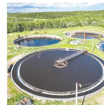
▲ ภาพที่ 5.18 สร้างบ่อดักตะกอนในการบำบัดน้ำเสีย ที่มา : คลังภาพ อจท.
