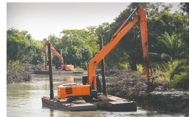
▲ ภาพที่ 5.15 ใช้รถแบ็กโฮช่วยในการขุดลอกแหล่งน้ำ เช่น คลอง บึง ที่มา : คลังภาพ อจท.
