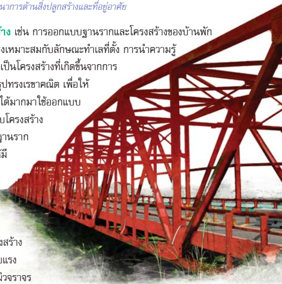
รูปที่ 1.13 สะพานซีลัว ประเทศไต้หวัน มีโครงสร้างแบบถัก
