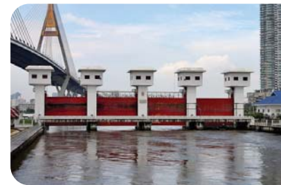
รูปที่ 1.25 ประตูระบายน้ำคลองลัดโพธิ์
