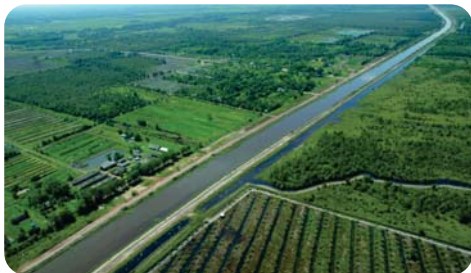
รูปที่ 1.23 การสร้างคันกันน้ำ การบริหารจัดการน้ำ โดยการก่อสร้างคันกันน้ำตามพระราชดำริ
