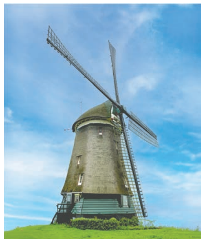
ภาพที่ 1.29 รูปทรงใบกังหันลมเหมือนกันตั้งแต่โคนถึงปลายใบกังหันลม
